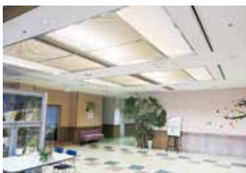
1階 エントランス(LED化)
