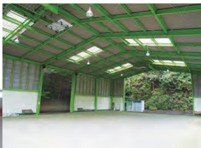
屋内ゲートボール場
